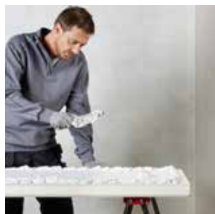
Verlijmen met kleefgips
