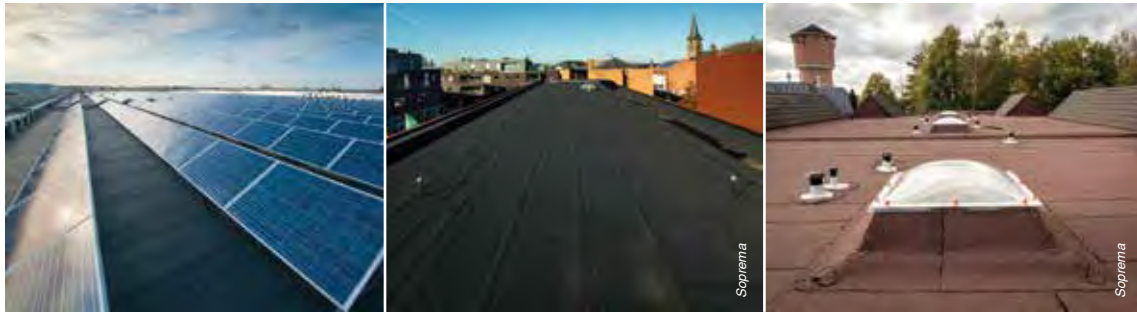
Afbeelding 7, 8 en 9: Bitumineus dichtingssysteem
